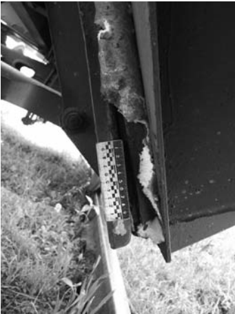
Рис. 7. Пошкодження монтажної піни
